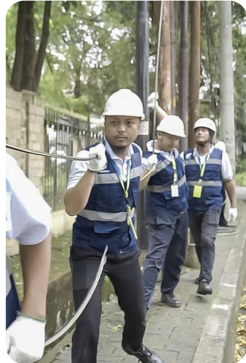
Pekerjaan Sipil Penarikan Kabel Fiber Optik
